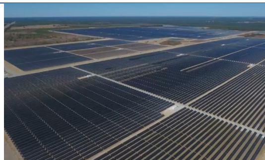
土耳其安卡拉 18MW 项目
