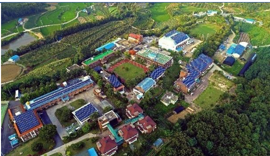
韩国 Andong500kW 项目
