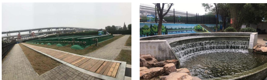
项目工程现场
