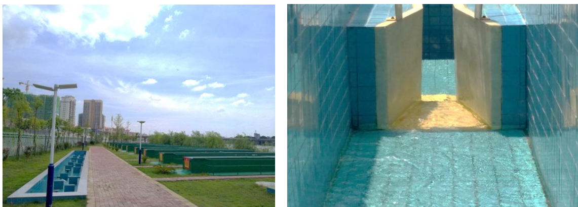
图 6-24 会昌县月亮湾新区污水处理厂项目情况
