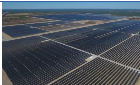
土耳其安卡拉 18MW 项目
