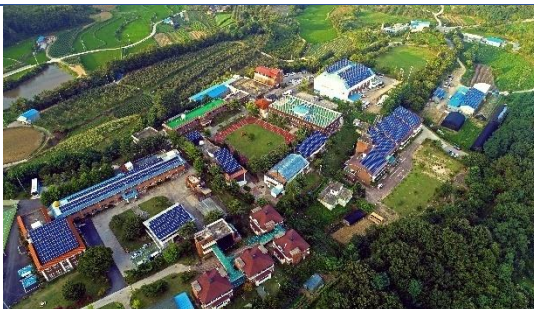
韩国 Andong500kW 项目
