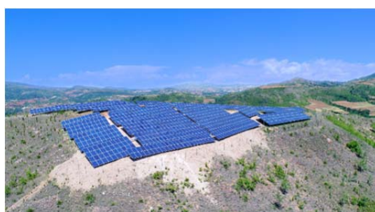
中国河南洛阳 25MW 项目
