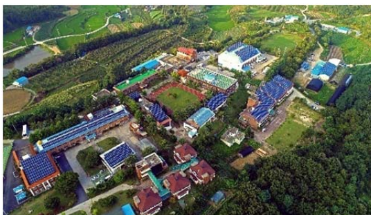
韩国 Andong500kW 项目
