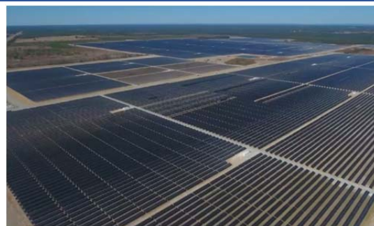
土耳其安卡拉 18MW 项目
