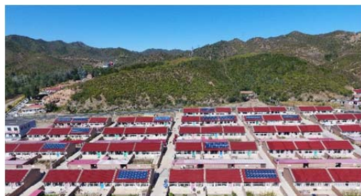
河北承德 19MW 项目
