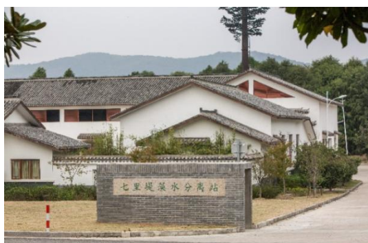
无锡七里堤藻水分离站 处理能力：藻浆 5,000 m 3 /d
