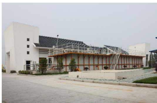
宜兴八房港藻水分离站 处理能力：藻浆 5,000 m 3 /d
