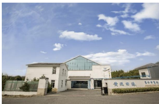
无锡黄泥田港藻水分离站 处理能力：藻浆 3,360 m 3 /d
