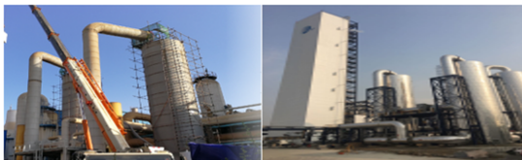
天安化工 5.2 万 Nm 3 /h 深冷空分装置
