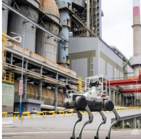
钢铁冶金厂巡检
