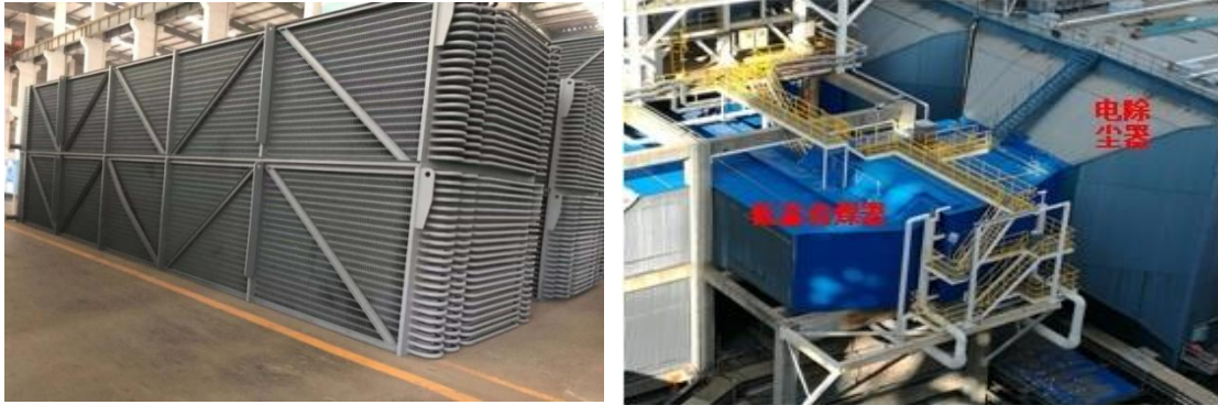
低温烟气余热深度回收系统实景图
