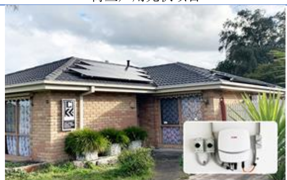
澳大利亚户用光伏项目
