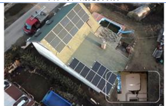
波兰户用光伏项目
