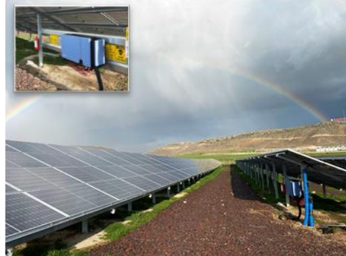
土耳其 6.55MW p 废水处理厂项目
