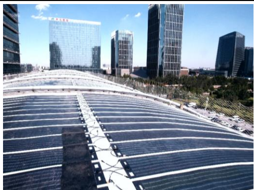
北京亦庄开发区 101kW p BIPV 项目
