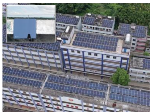
海南省定安县 2.74MW p 整县推进项目
