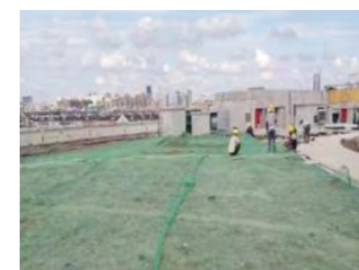
● 屋面裸土及时跟进覆盖
