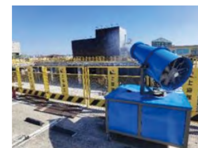
● 拆除阶段雾炮机降尘
