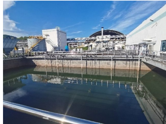
工业废水处理站
