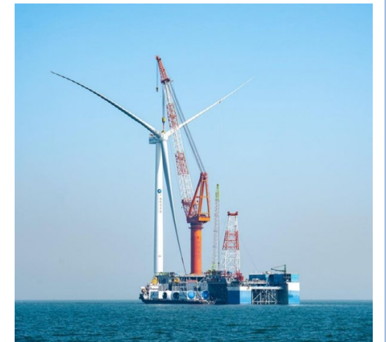
广西防城港海上风电示范项目
