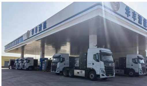
华丰加氢综合能源服务区项目
