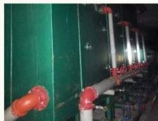
新集二矿矿井水井下复用工程
