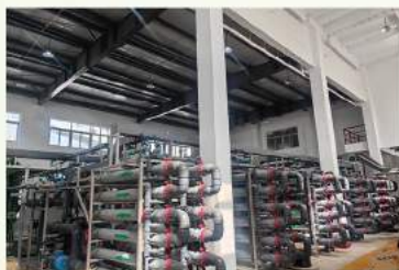
板集煤矿矿井水深度处理工程
