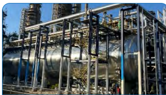
三级电脱盐改造项目顺利投用
