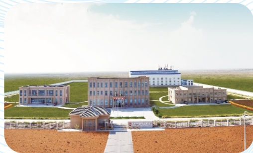
• 鄯善县菱镁矿产业园
