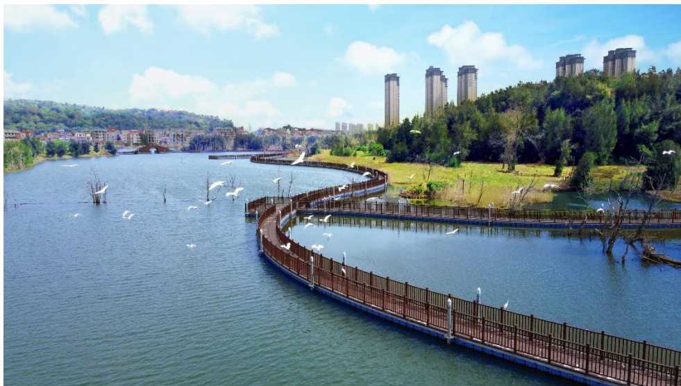
广州南沙灵山岛尖外江生态提升 EPC 项目
