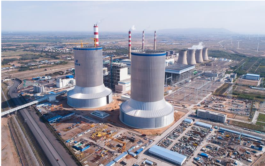
华能集团宁夏大坝电厂 2x660MW 一机一塔间冷钢塔项目
