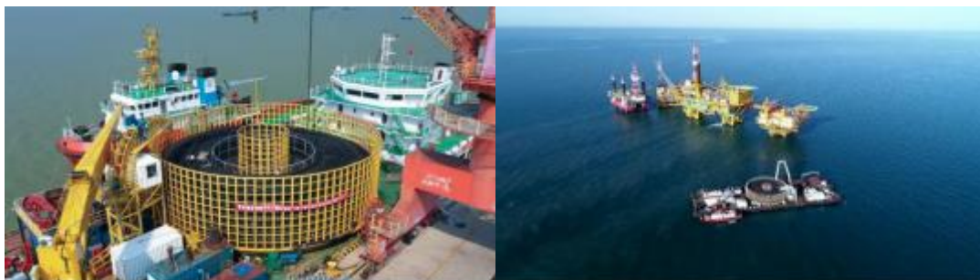
图5 亨通海上风电项目
