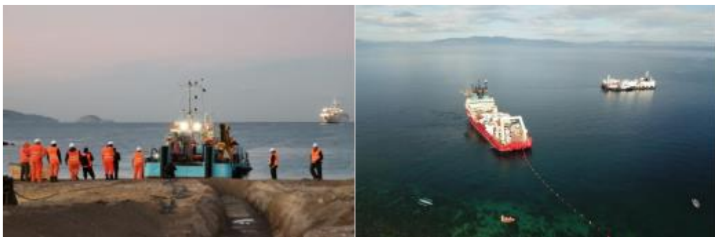
图 12 重大跨洋海缆通信系统项目建设
