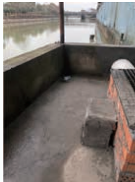
修补加高防水墙
