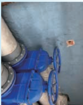
更换大口径雨水管
