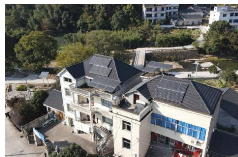
图：“消薄”席家村屋顶光伏发电项目，预计为村集体增收 16 万元/年
