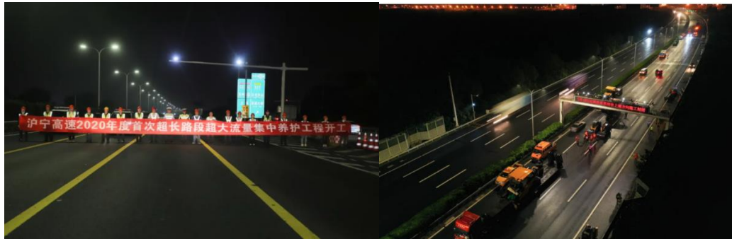
图注：“2.0”超大流量高速公路集中养护样板——沪宁高速公路硕放枢纽-苏州北枢纽路面养护工程
