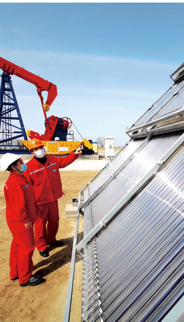
胜利油田孤岛厂应用太阳能自控加热装置助推绿色生产
