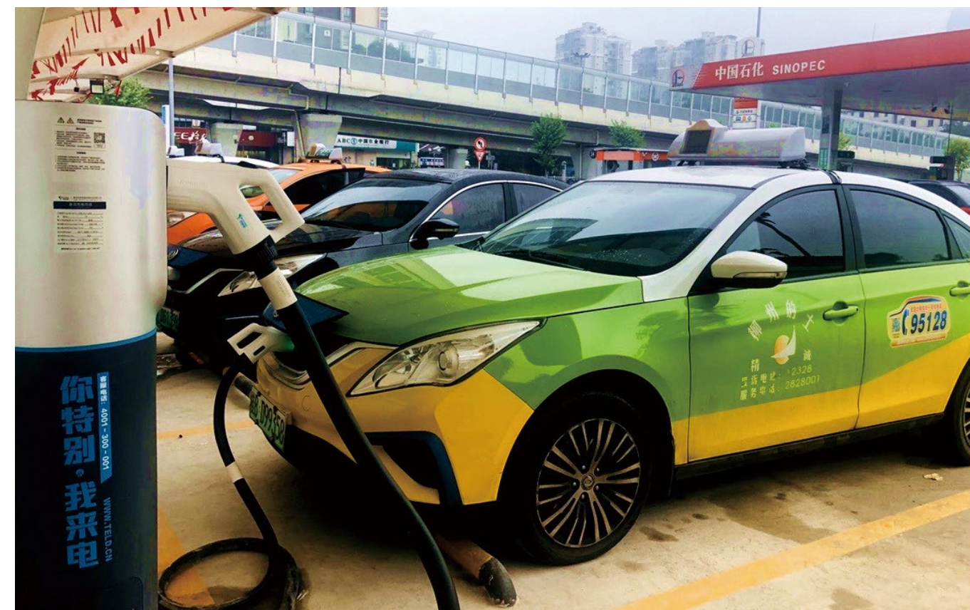
新能源出租车在中国石化充电站内快捷充电
