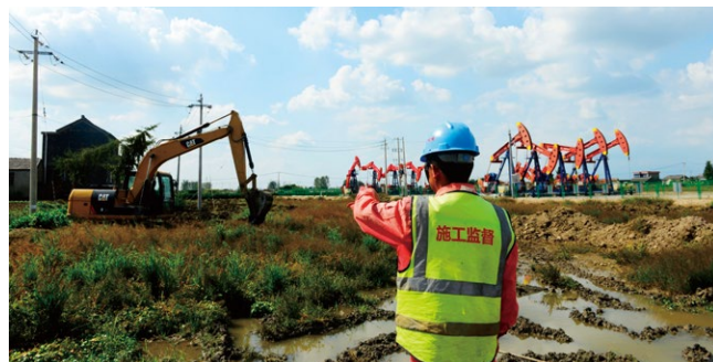
④ 华东石油局泰州采油厂职工在仓西 3-9 平台指挥复垦施工
