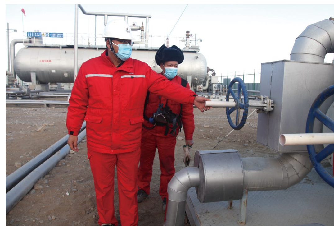
④ 安全管理人员对 顺北 5 现场隐患排查
