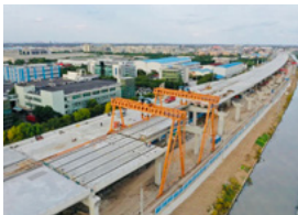
PC构件装配式技术施工,实现对预制构件下单、生产、仓储等全过程管控
