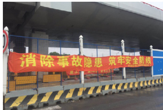
在建项目工地安全生产宣传
