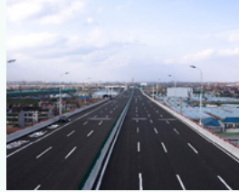
机场北通道排水降噪沥青路面
