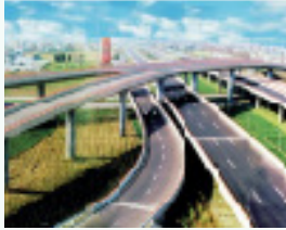
远东大道—迎宾大道立交工程荣获中国建设工程鲁班奖
