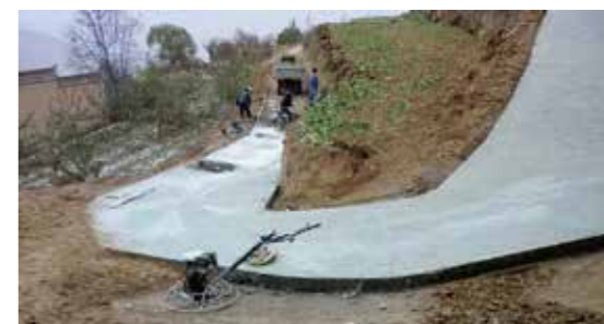
帮扶甘肃甘谷老庄村修筑进村道路
