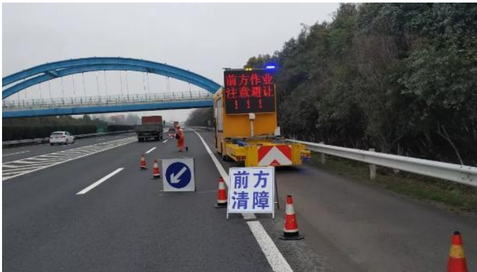
图注：清障人员使用“智能主动预警装置”施工作业
