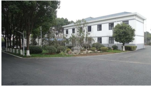
图注：玉祁站完成整体景观后的园林风格站区
