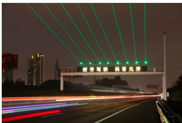
图注：空中激光光束配合情报板警示
