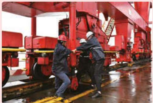
现场设备加固
