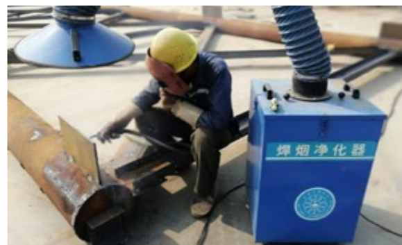
中国十九冶集团焊烟收集净化装置
