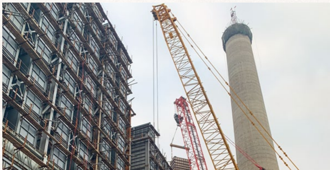
2*265 平方米烧结烟气综合治理提升改造工程项目
