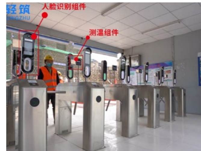
中冶赛迪“轻筑”智能门禁测温系统在对工作人员进行检测
