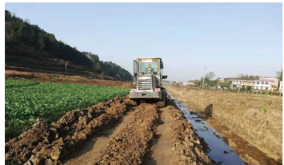
河道改造及机耕道修建
