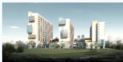
上钢社区综合服务中心新建工程 工程性质：区重大工程 项目金额：2.8 亿元
