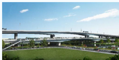
崧泽高架西延伸段 2 标 (K1-K7) 工程性质：上海市重大工程 项目金额：14.2 亿元
