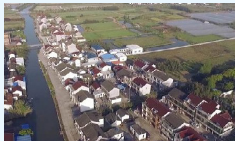
▶ 川沙新镇连民村污水治理工程
