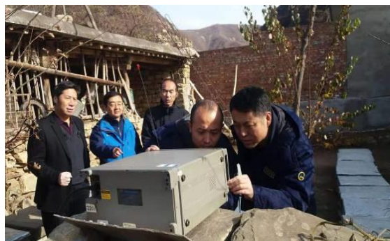
维修通信广播系统
