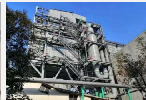
► 湖北新冶钢焦化炉SDS干法脱硫除尘、SCR脱硝项目
