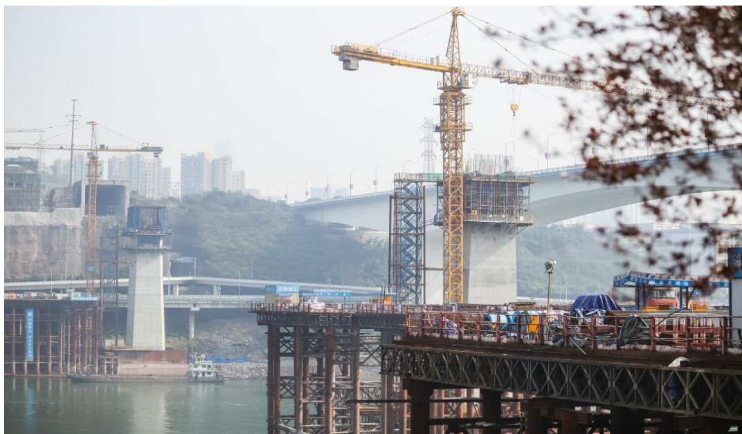
重庆轨道九号线施工现场
