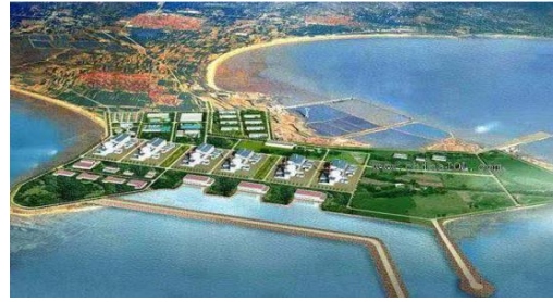
图 7：山东石岛湾核电站
