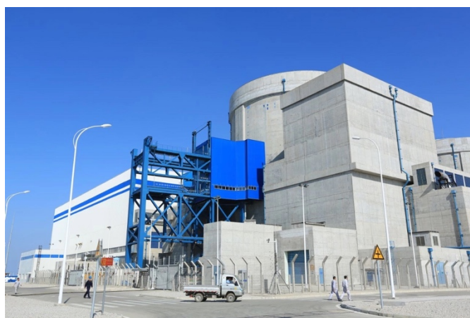
福清核电 1 号机组核岛安装工程
