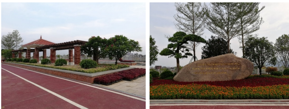
木兰溪堤岸工程
