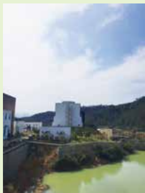
支持垃圾发电项目
