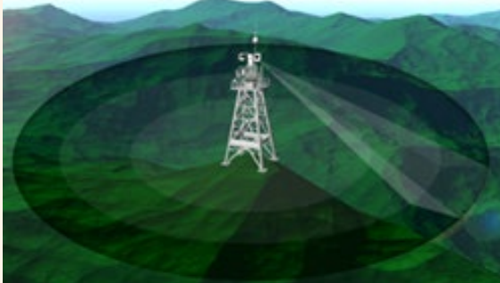
铁塔上的热成像摄像机全天候 24 小时不间断巡航
