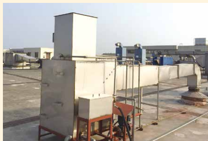
5. 胡庆余堂药业有限公司投资 0.7 万元自行设计制造二套 QY-1 水沫除尘器 (型号自定, QY 是庆余的意思), 消除粉尘超标排放的环境隐患。公司技术部已经将此设计申报实用性专利, 目前在审批过程中
