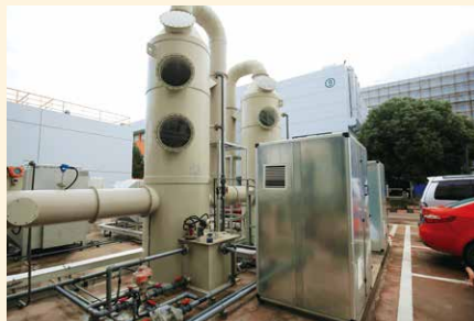
3. 上药第一生化投资 56 万元配置辅酶 A 车间废气治理设施
