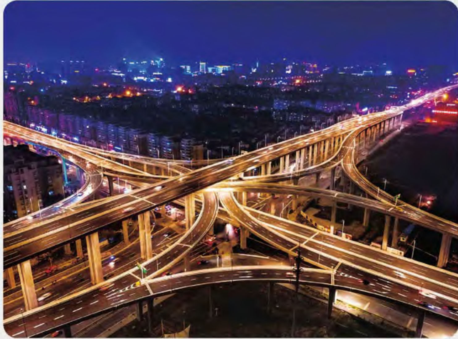
盐城分行贷款支持的盐城市区内环高架
