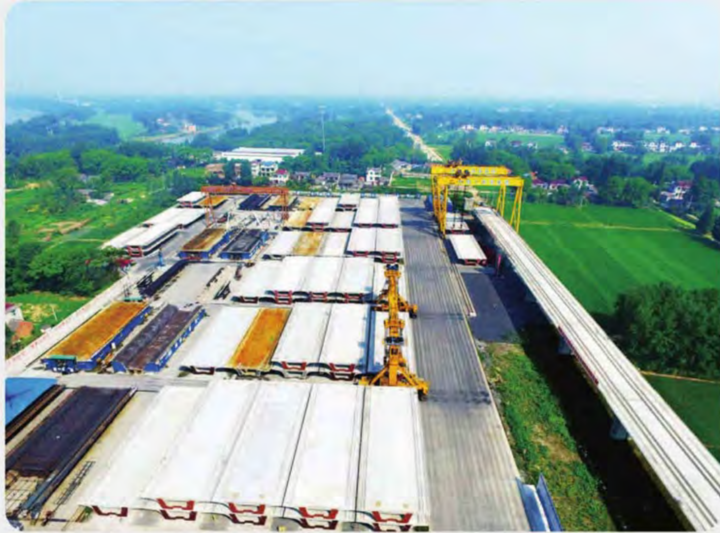
扬州分行投行工具支持的连淮扬铁路施工现场
