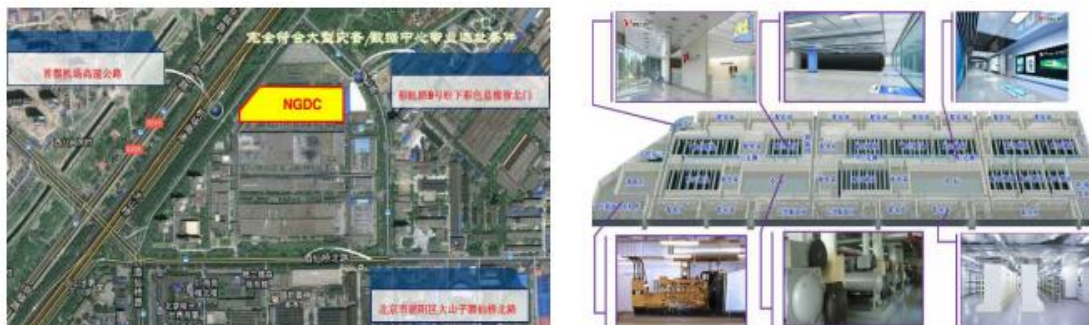
图 酒仙桥机房地理位置、机房基础设施
