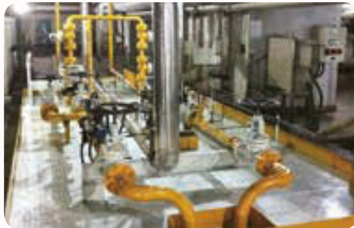
营口电厂二期炉侧燃油平台整改前后对照图
