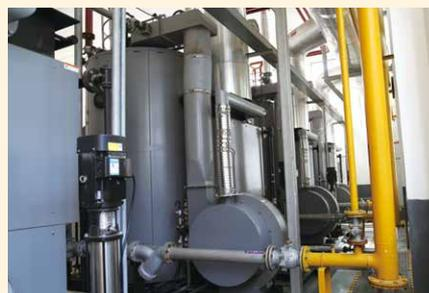
2. 上药中西投资 7 万元配置 4 台燃气锅炉加装烟气再循环系统 (EGR), 利用部分烟气温度降低炉膛火焰温度, 可减少氮氧化物的产生。改造后氮氧化物排放浓度下降 56%, 全年可减少氮氧化物 2.6 吨左右
