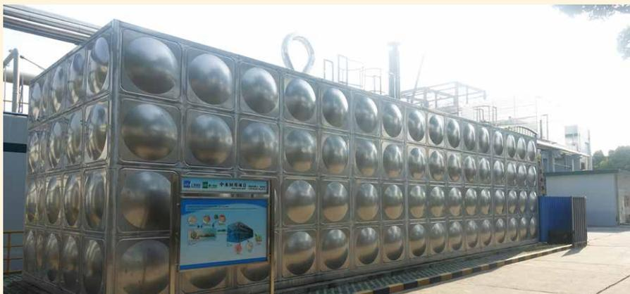
3. 上药第一生化投入资金 80 万元, 建设一套设计能力为每小时 50 吨的污水再利用处理系统。目前已投入使用, 每天生产 200 吨左右的回收水, 用于绿化和洁具冲洗以及锅炉用水等
