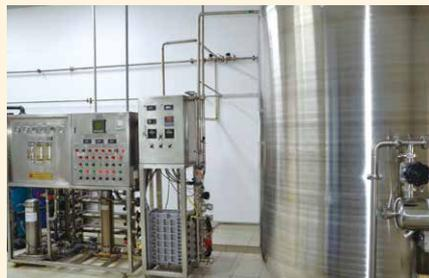
2. 上海信谊天平药业有限公司投资 4.6 万元建立纯化产生浓水的收集、储存和再利用。项目建设完成后, 纯化浓水将用于卫生间等处的冲洗用水。经计算每年可节约用水 6000 吨
