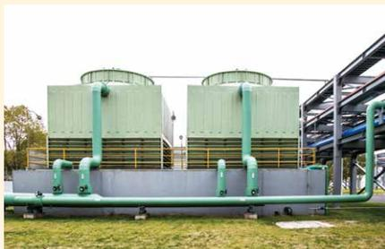
1. 上药中西三车间纯化水制备耗水量较大, 每小时有 4 吨反渗透浓水直接排放。而工厂冷却塔循环补水每天需要 30 吨。经过调研企业投资 10 万元建设反渗透浓水回收利用作为冷却塔补充水的项目。运行后每年可节约用水量 9000 吨
