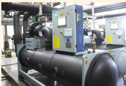
1. 上海信谊金朱药业有限公司采用合同能源管理方式更新两台磁悬浮离心式冷水机组综合能效比达到 8.9 采用环保冷媒, 保护臭氧层, 采用无油润滑系统, 能效提升 8%。每年可节电 28 万 kwh, 减少 85 吨标煤
