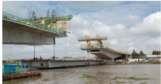
△ 中间段箱梁吊装
