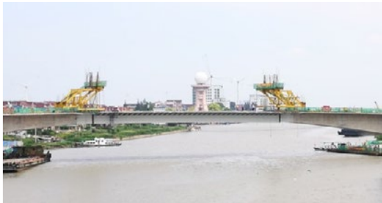
△ 中间段提升到位立面
