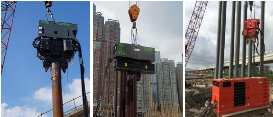
液压免共振锤施工示意图
