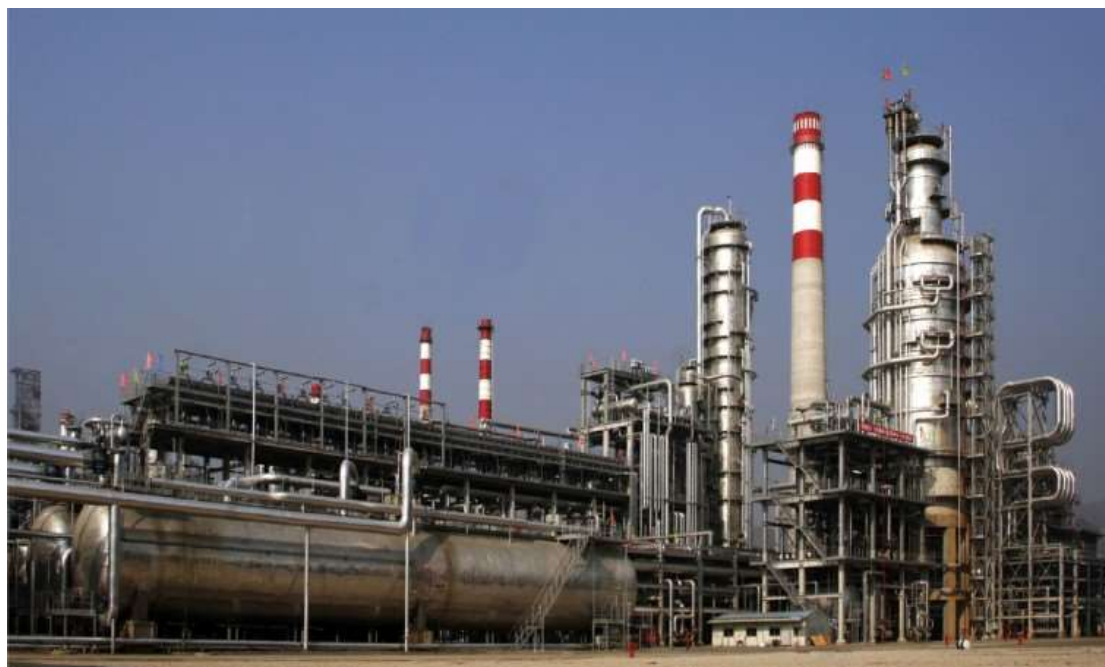
（中海油惠州 1200 万吨/年常减压蒸馏装置）
