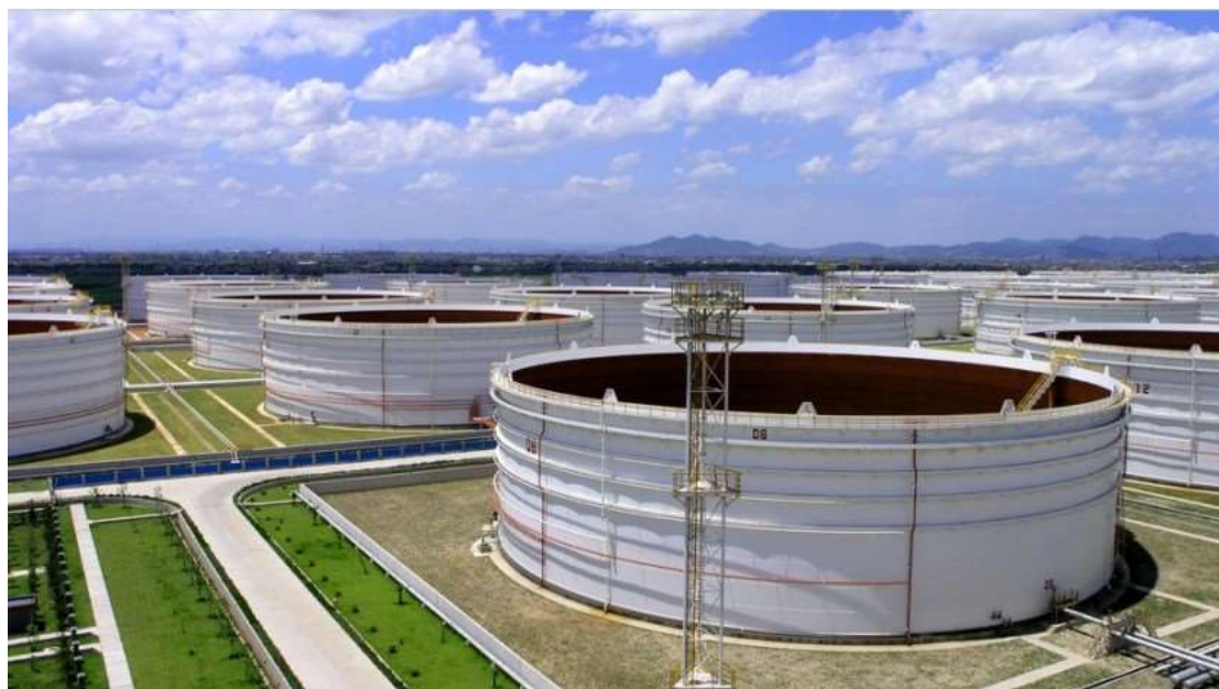
（镇海国家石油储备基地）
