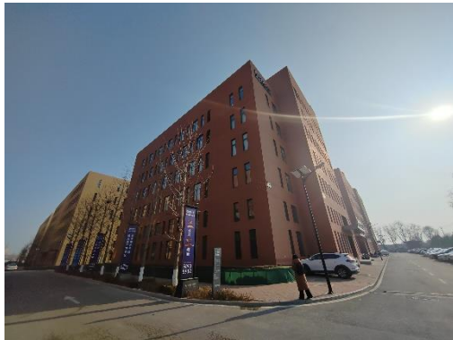
南侧联东U谷·马坡科技园二期项目
